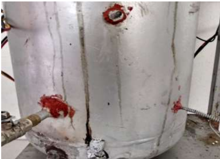
Figura 22. Sellado de juntas de diversos elementos del reactor.
